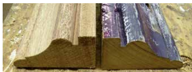
Gekopieerd profiel (links) in verkeerde houtsoort (meranti) en maatafwijkingen t.o.v. origineel (rechts)
