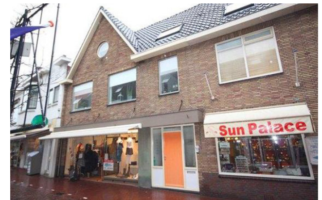
referenties Spoorstraat met verschillende kappen 61
