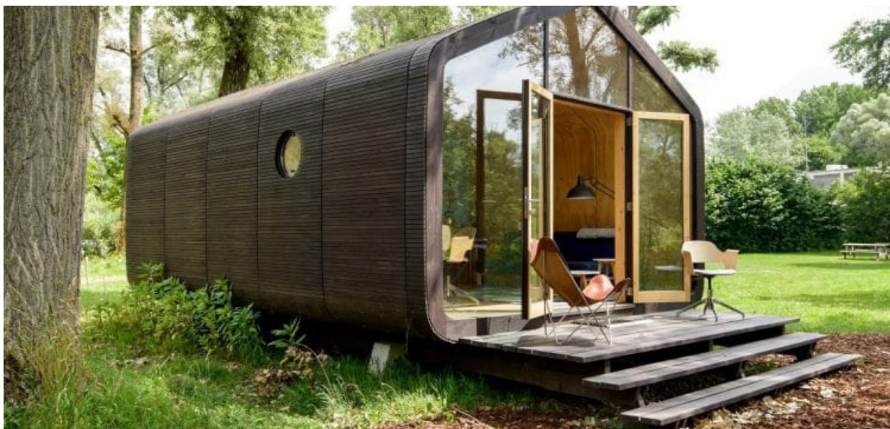
Afbeelding 05: Wikkelhuis in Dordrecht, van Vision Factory. Gemaakt van karton, heeft levensduur van minimaal 50 jaar en 100% te recyclen.
