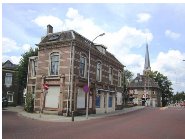
Winkelwoonhuizen aan de Emmastraat (gemeentelijk monument ).
