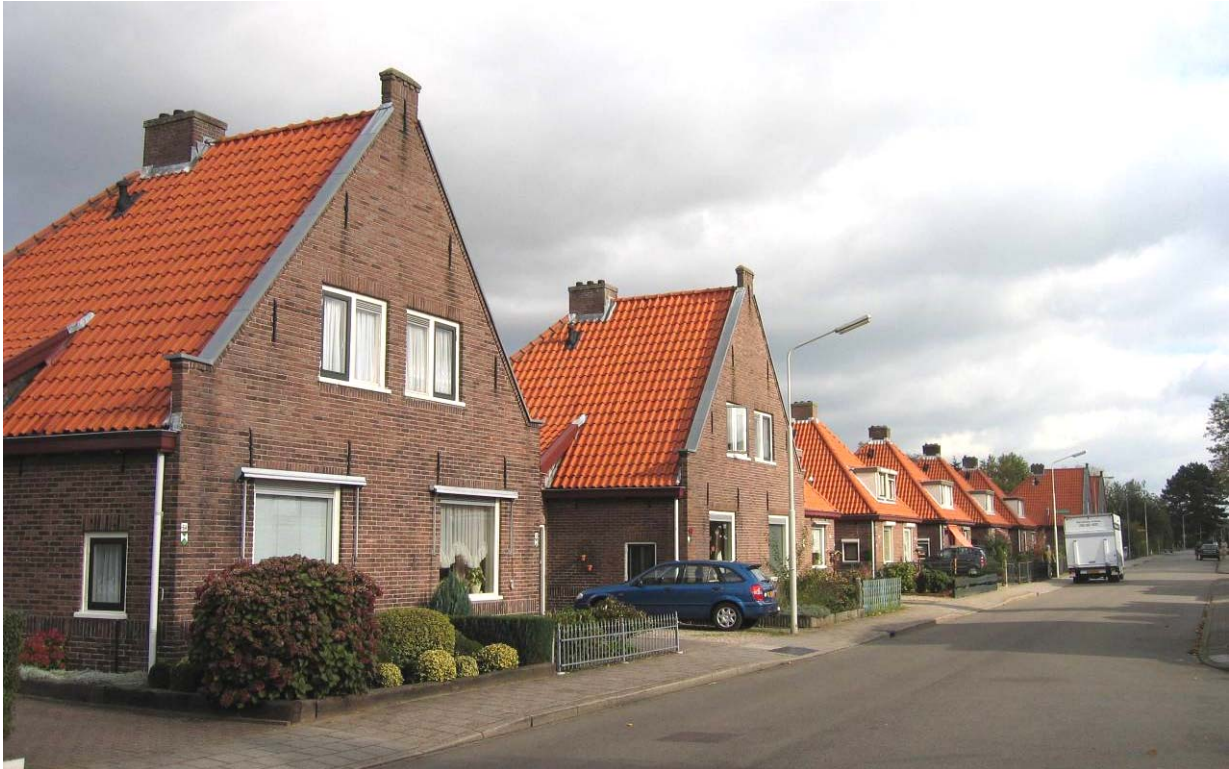
Landarbeiderswoningen aan de Worth-Rhedenseweg 30-64 (1918-1922) van de architect ir J.H.W. Leliman (1878-1921).
