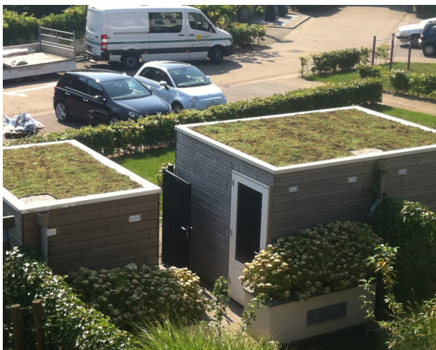
Referentie: sedumdaken op bergingen
