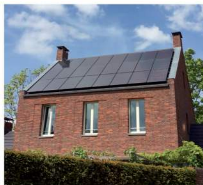
Voldak systeem geeft meestal een rustig beeld.
