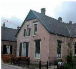
Bebouwing aan de Lagestraat - 2e Orde zone.
