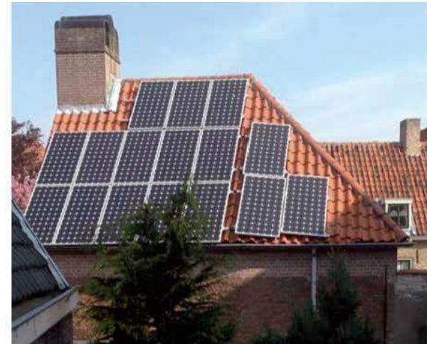
Panelen worden nogal eens in een grillige vorm op het dak gelegd rondom dakkapellen, dakramen en schoorstenen.
